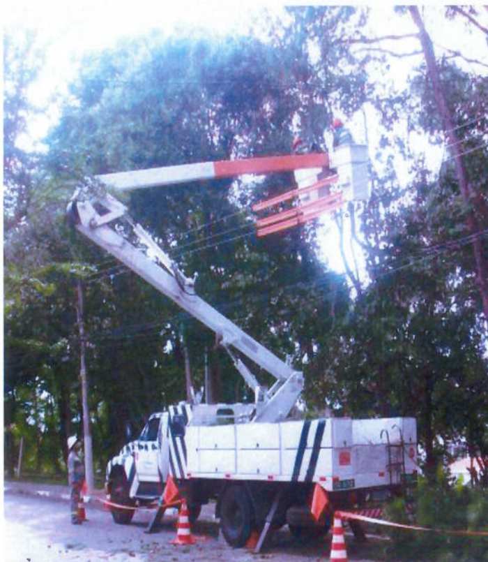
Figura 30: Caminhão com cesto elevatório e sinalização da área. Fonte: (Arquivo Pessoal, 2011)
