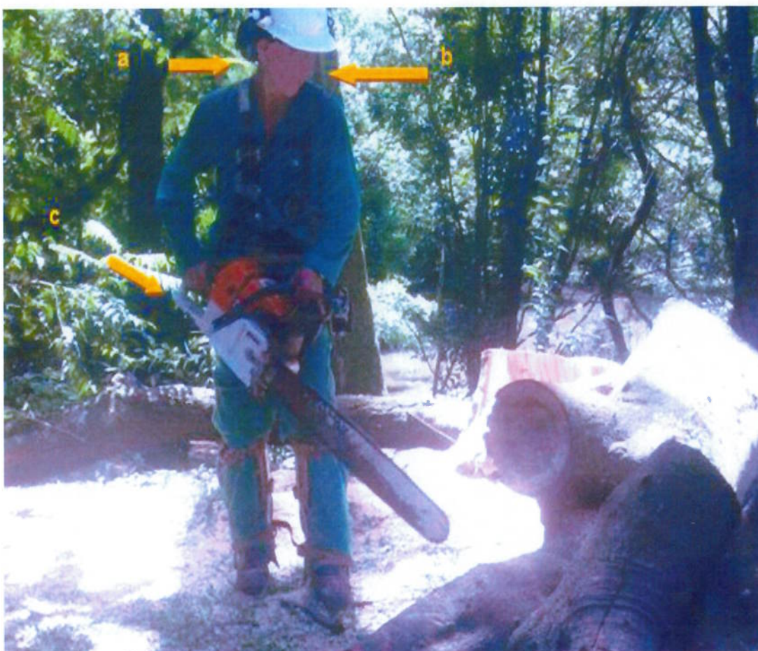
Figura 40: Operador sem o uso dos EPI's: (a) protetor auricular atrás da orelha, (b) sem óculos, (c) sem luvas.
