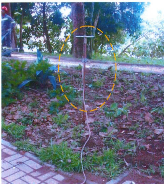
Figura 31: Aterramento do caminhão. Fonte: (Arquivo Pessoal, 2011)
