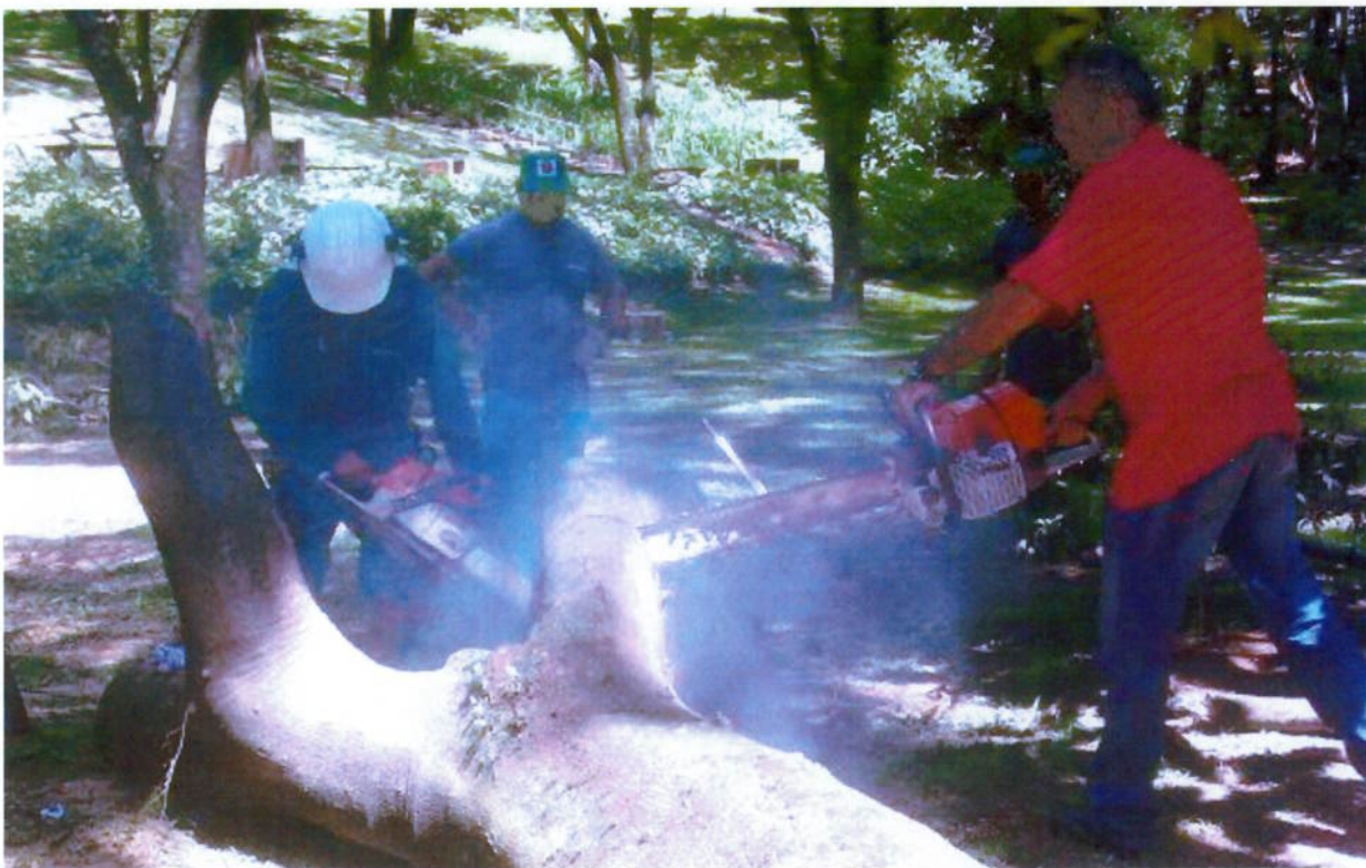
Figura 41: Emperramento da madeira e motosserra presa. Fonte: (Arquivo Pessoal, 2011)
