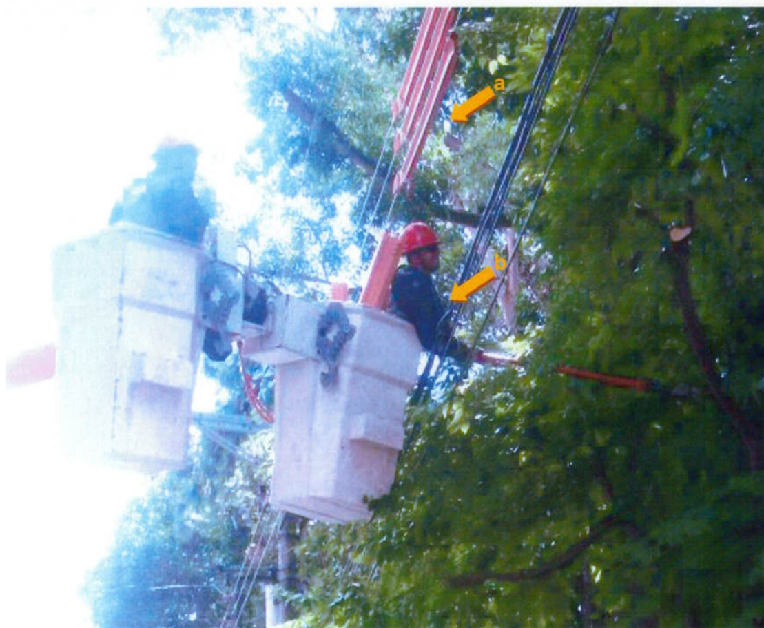
Figura 34: (a) posicionamento das coberturas de proteção; (b) manga isolante de borracha utilizada pelo operador.
