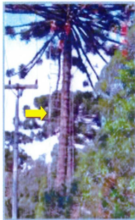
Figura 14: Andaime montado na árvore Fonte: (RGE, 2005)
